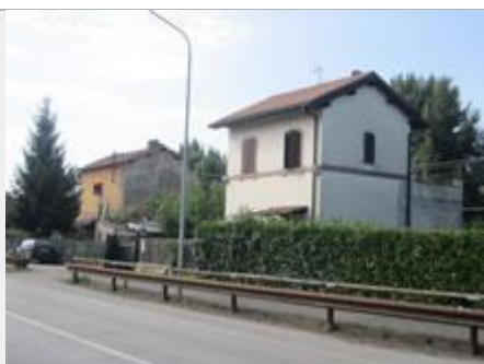
Stazione di Umbertide della Ferrovia Centrale Umbra, tuttora in esercizio, che sorge di fronte a quella dismessa della FAC (A. Stigliani, 2017)
