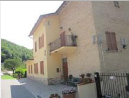
Altra immagine del casello adibito ad abitazione privata tra Pietralunga e Mocaiana (A. Stigliani, 2017)
