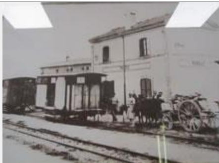
Immagine storica della stazione di Padule, oggi non più esistente (A. Stigliani, 2017)
