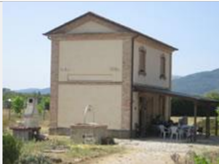
Altra immagine del fabbricato viaggiatori della ex-stazione di Serrapartucci (A. Stigliani, 2017)
